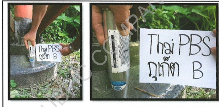
รูปที่22 ภาพตรวจความแข็ง (Strength) ของคอนกรีตฐานราก B=460 KG/CM 2
