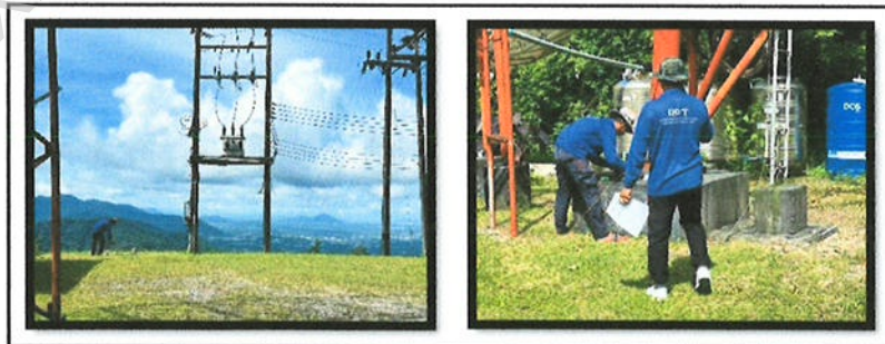
รูปที่9 ตรวจสอบสภาพทั่วไป
