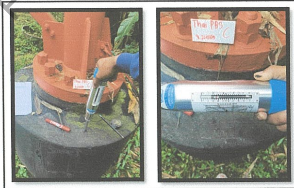
รูปที่ 21 ภาพตรวจความแข็ง (Strength) ของคอนกรีตฐานราก C=359 KG/CM 2
