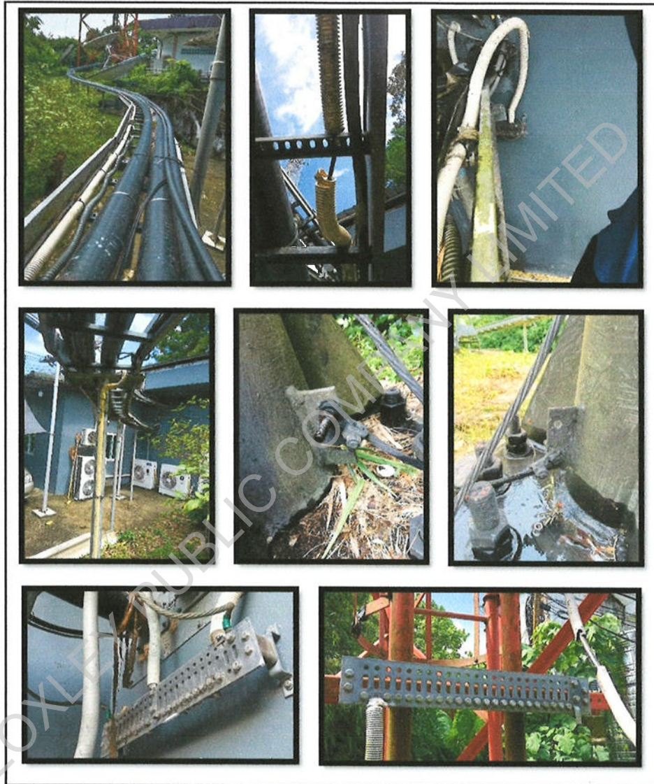
รูปที่ 39 ตรวจสอบบาร์กราวด์ พบมีสภาพผิวสีกร่อน ลอกกร่อนเป็นบางจุด
