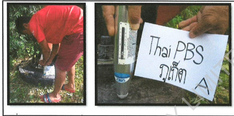
รูปที่21 ภาพตรวจความแข็ง (Strength) ของคอนกรีตฐานราก A=460 KG/CM 2
