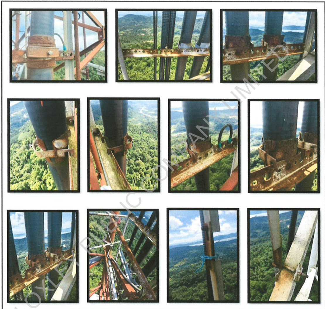
รูปที่33 ตรวจสอบ Vertical Ladder สำหรับจับแคว้นสายสัญญาณ พบชำรุดเสียหาย เนื่องจากสนิมจำนวนมาก
