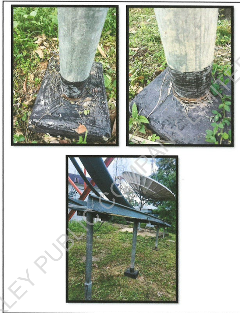
รูปที่ 38 ตรวจสอบขา Ladder พบชำรุดเป็นสนิมบางส่วน
