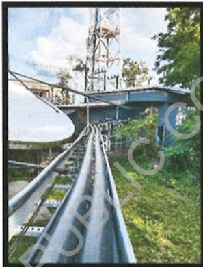
รูปที่10 Horizontal Feeder Rack
