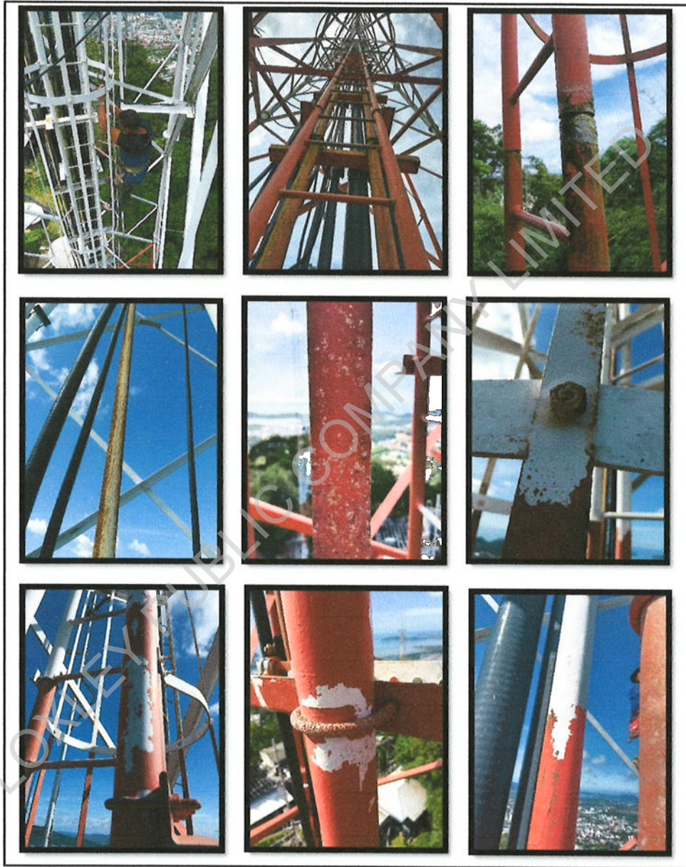
รูปที่34 ตรวจสอบบันไดเป็นเสาสูงๆ เกิดสนิมหลายจุด สีสกร่อนเป็นแผ่น Bolt-Nut ,ยูโบลท์ ที่ยึดจับโครงสร้างบันได เป็นสนิม
