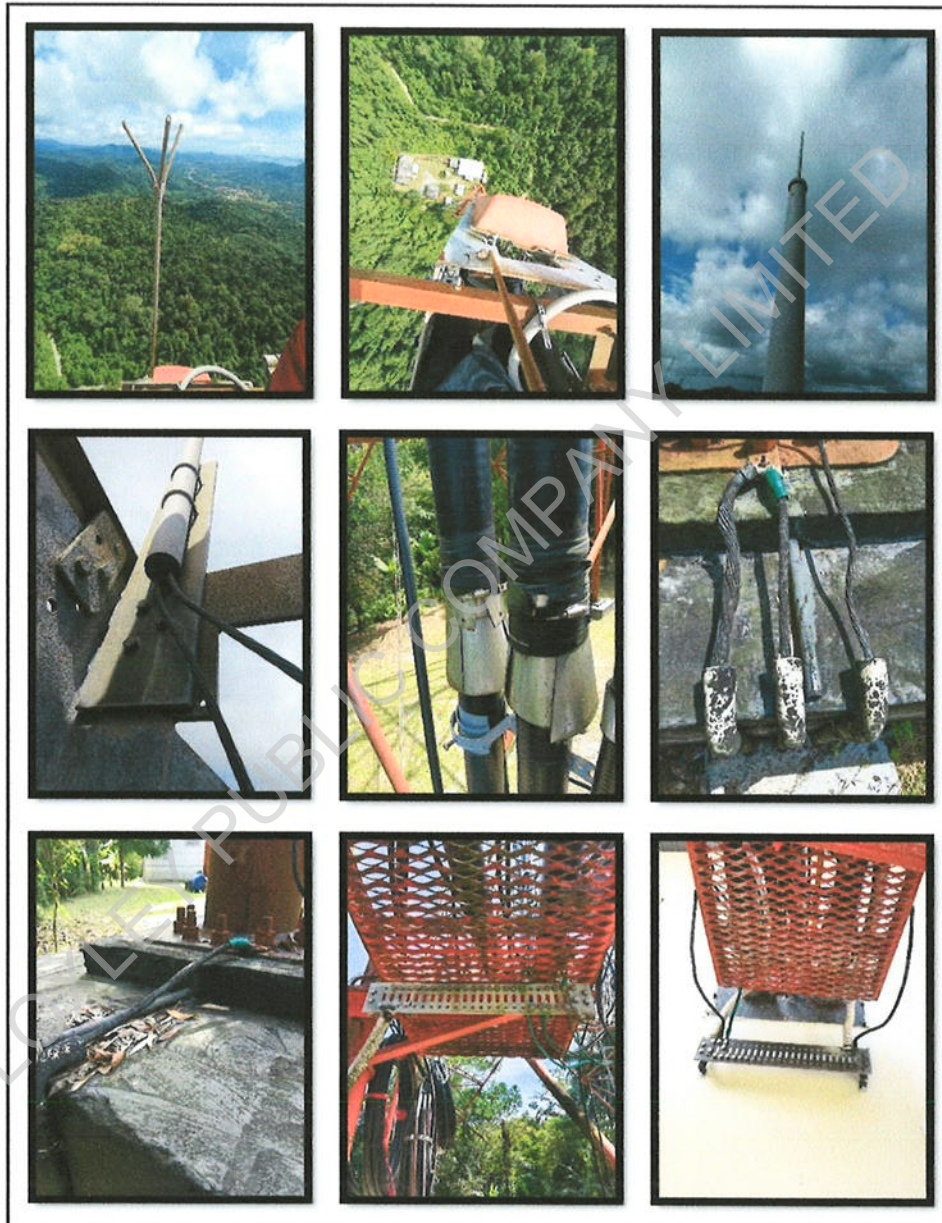
รูปที่ 17 Ground และระบบต่อฟ้า
