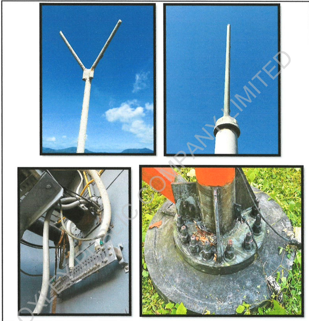
รูปที่ 20 Ground และระบบต่อฟ้า
