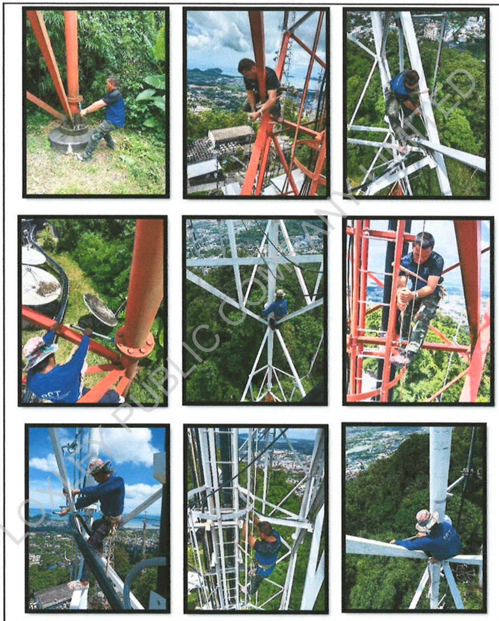
รูปที่10 ตรวจสอบความแน่น Bolt & Nut ด้วยเครื่องมือประแจ TORQUE
