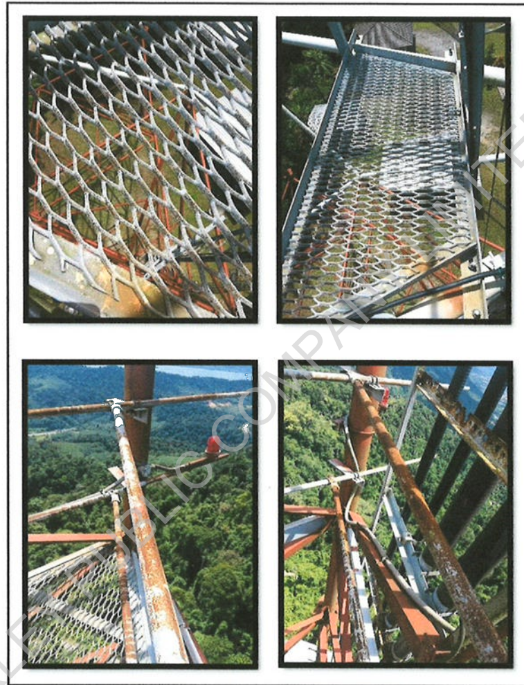
รูปที่31 ตรวจสอบสภาพ ขานพัก Platform และ เหล็กกราวกันตง พบสนิมบางจุด สีเริ่มซีดจาง
