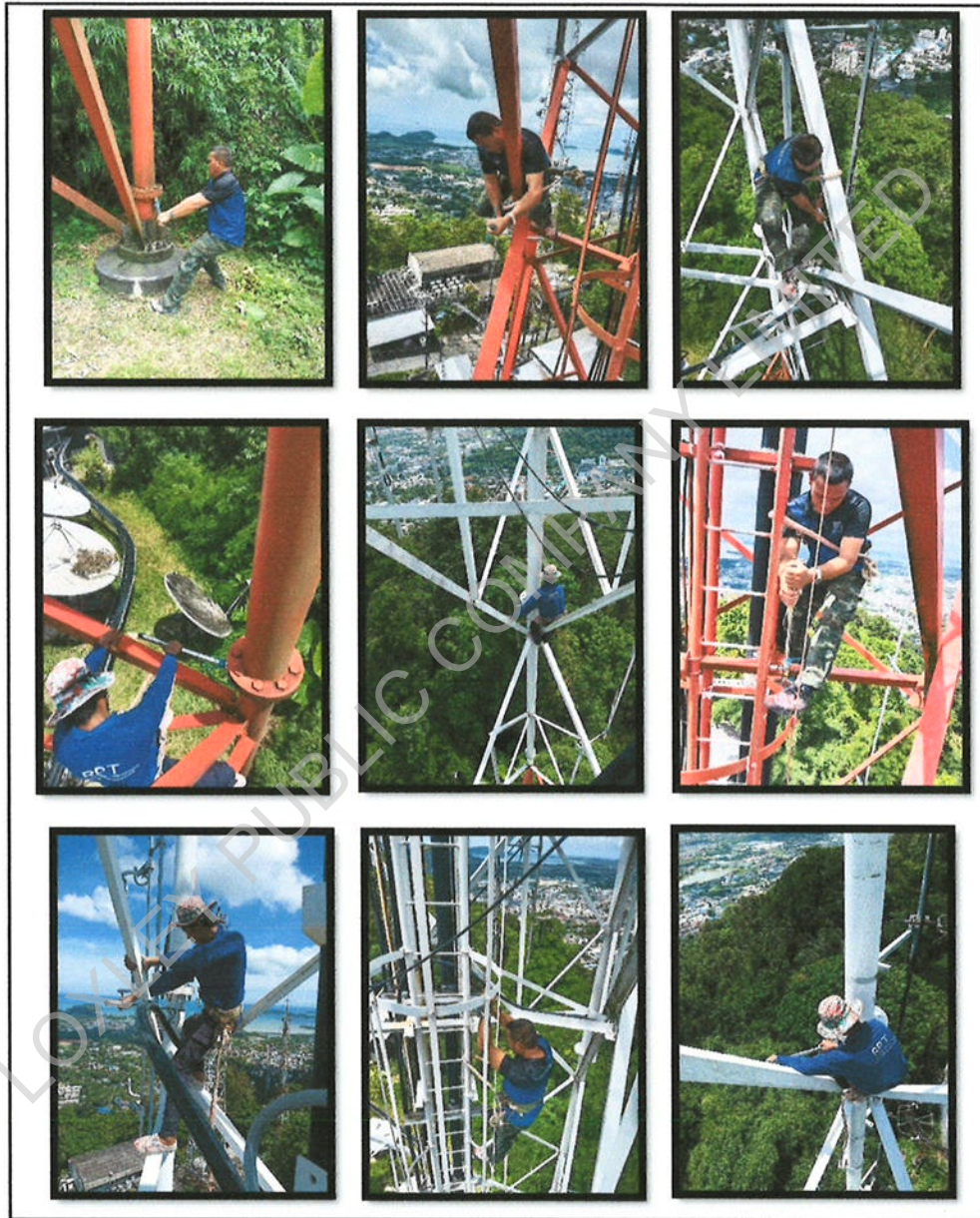
รูปที่13 ตรวจสอบความแน่น Bolt & Nut ด้วยเครื่องมือประแจ TORQUE
