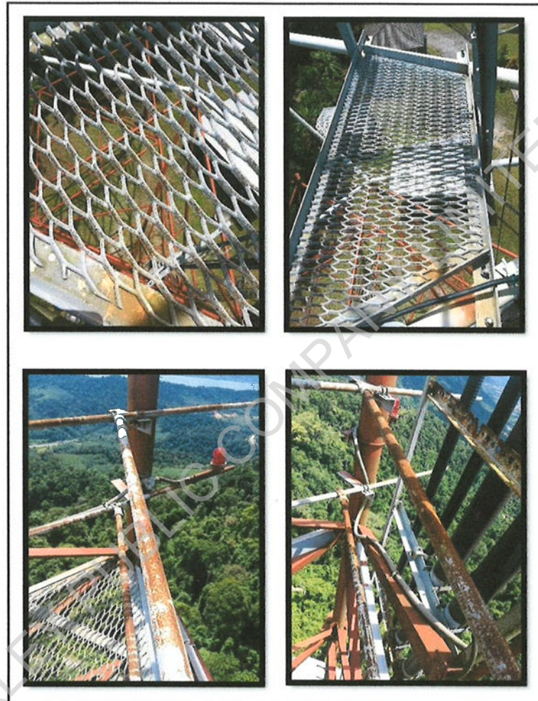
รูปที่31 ตรวจสอบสภาพ ขานพัก Platform และ เหล็กกราวกันตัก พบสนิมบางจุด สีเริ่มซีดจาง
