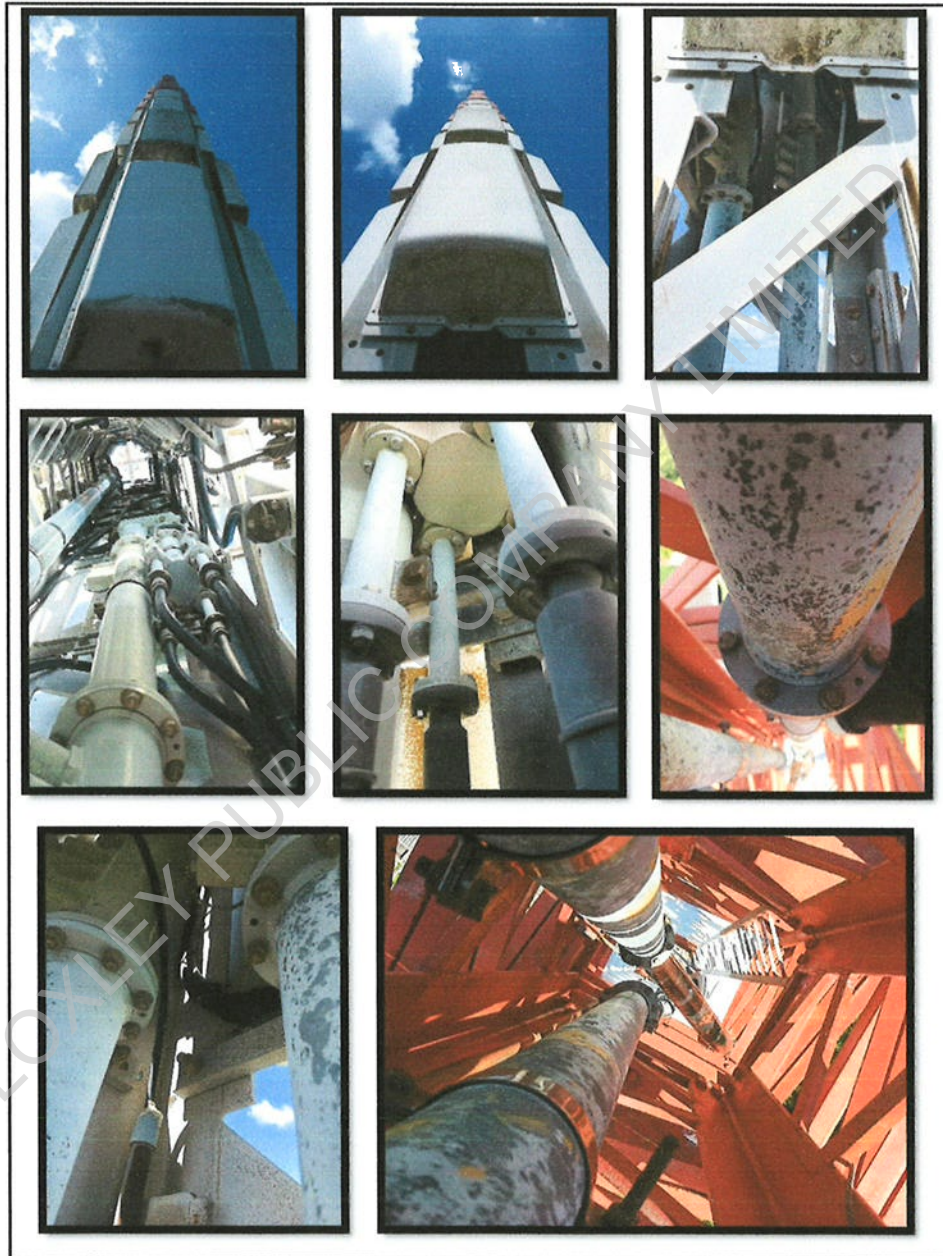
รูปที่26 ตรวจสอบแผงอุปกรณ์ส่งสัญญาณอยู่ในสภาพสมบูรณ์
