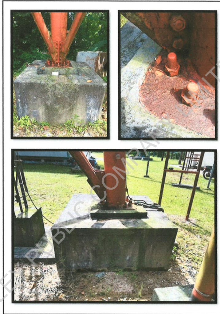
รูปที่37 ตรวจสอบสภาพสีฐานเสาส่งฯ พบสีเริ่มซีดจางลอกกร่อน
