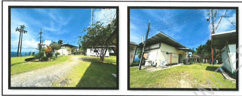
รูปที่11 สภาพพื้นที่บริเวณโดยรอบเสาส่งฯ
