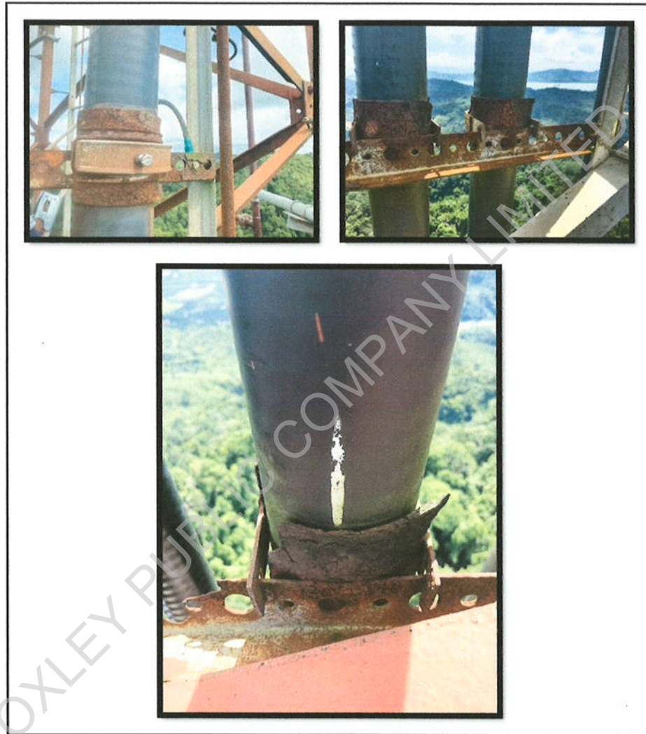
รูปที่ 32 ตรวจสอบแคล้มจับสายสัญญาณเสาอากาศ เป็นสนิมเกือบทุกตัว แก้ไขโดย เปลี่ยนแคล้มจับสายใหม่
