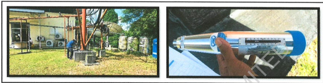
รูปที่18 ภาพตรวจความแข็ง (Strength) ของคอนกรีตฐานราก A=398 KG/CM 2
